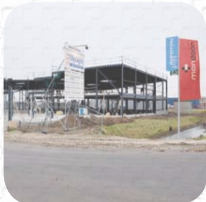
▲ Het nieuwe bedrijfspand van Mondoor aan de Heksekamp in Zaltbommel.
